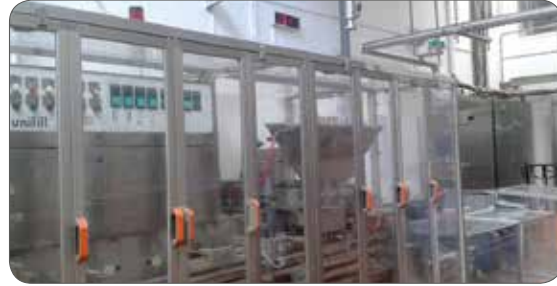
Şekil 17: Makinenin tamamının koruyucular ile izole edilmesi
