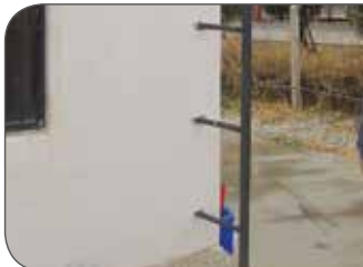
Şekil 7. Düşme riski oluşturan bir merdiven
